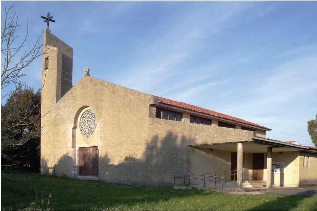
(Fig. 9) Santa María, Baio (A Coruña), 1981; estado actual (exterior). Esteban Fernández-Cobián.
