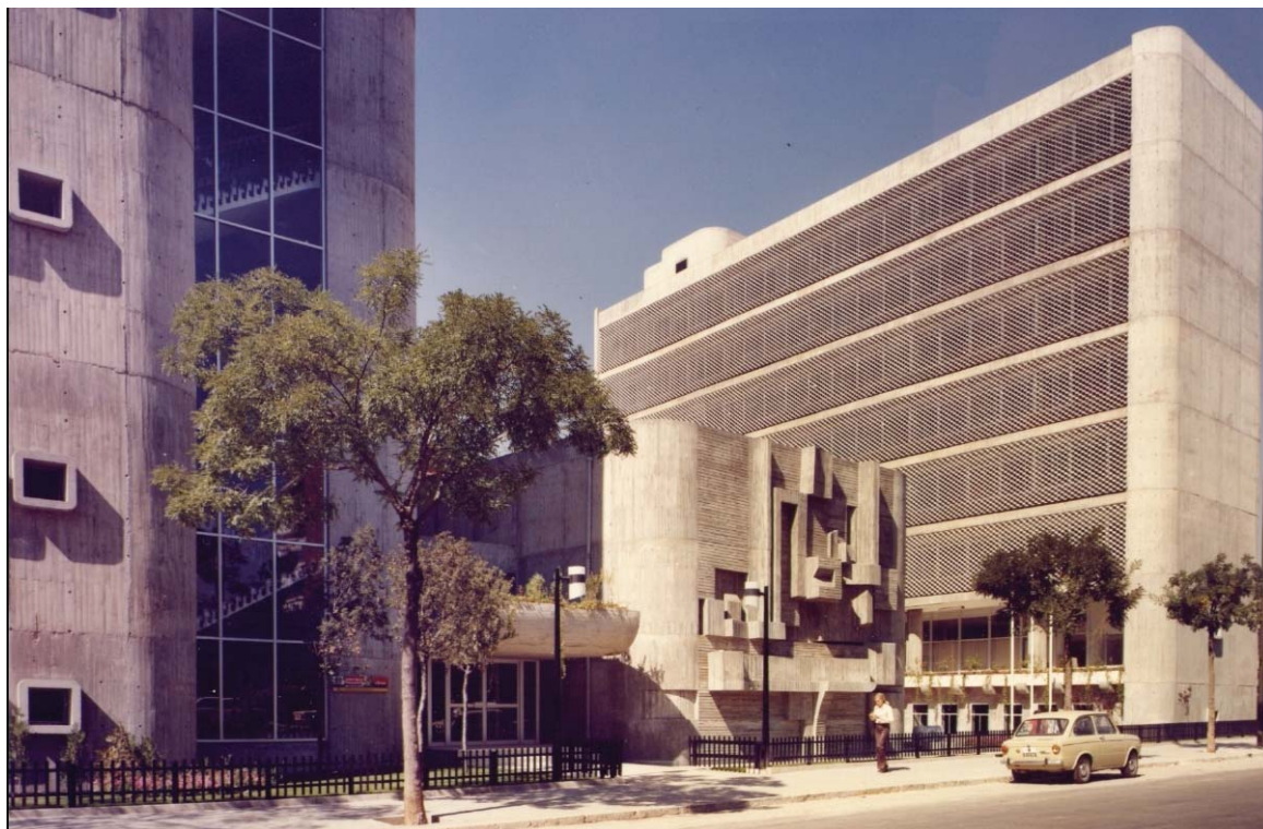
(Fig. 9). Centro de Promoción Social Obrera , Madrid, 1970-73. Acceso principal C/. Víctor de la Serna con relieve de Javier Clavo sobre el cerramiento del Aula Magna. Fondo Moreno Barberá, AH-CTAV
