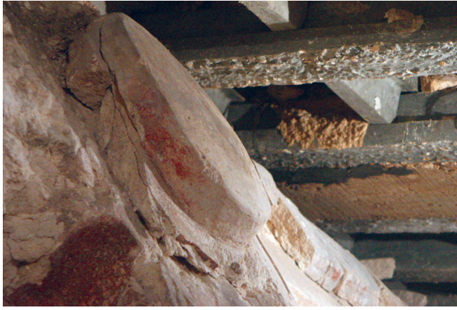
FIGURA 7. Voluta modelada en estuco, cuyo desprendimiento muestra que se aplicó sobre un primer nivel de recubrimiento una vez modelada (Fotografía: Claudia A. García Solís, 2002; fuente: García, 2011, cortesía: INAH).
