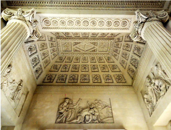
Fig. 5: Interior de la puerta principal de la Capilla del Carmen de Saint-Denis con el relieve de Deschamps de "La Déposition de la Croix" de Deschamps
