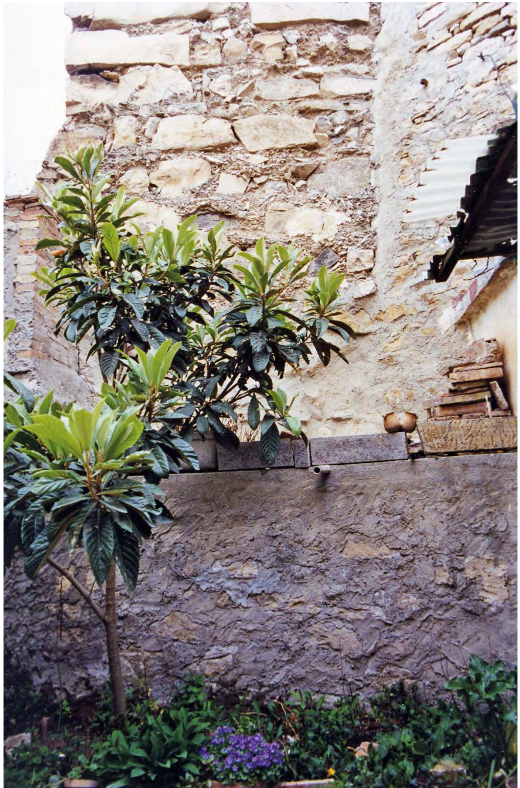
Figura 24. Possible tram de la muralla, a la part inferior de la imatge, i vista en secció de l'extrem est del mur sud del segle XV, en el punt on s'entregaria a la muralla de Pere III.
