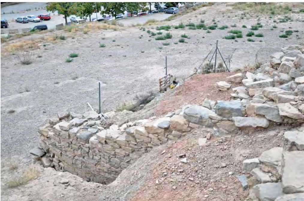
Figura 15. Mur corresponent a una possible torre situada a la part baixa del vessant sud.
