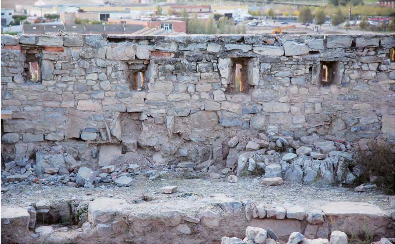
Figura 18. Detall de les espitlleres del mur sud de la fase de reforçament del castell durant les guerres carlines del XIX. Mur bastit damunt del tancament del segle XV.
