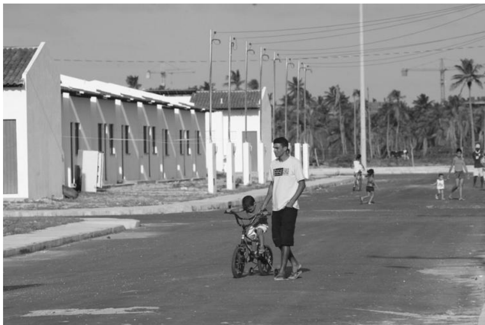
Figura 04- Casas construídas na primeira etapa no Bairro 17 de Março em 2010 para abrigar moradores removidos do Morro do Avião, no Bairro Santa Maria em Aracaju.
