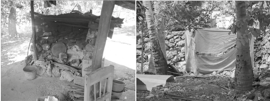
Figura 2b. Letrina hecha de láminas de aluminio colocada en la parte trasera del patio
