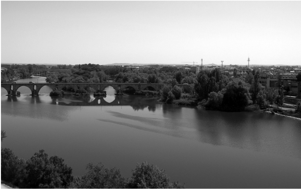
Fig. 2. Aspecto actual del puente de Piedra (fotografía del autor).
