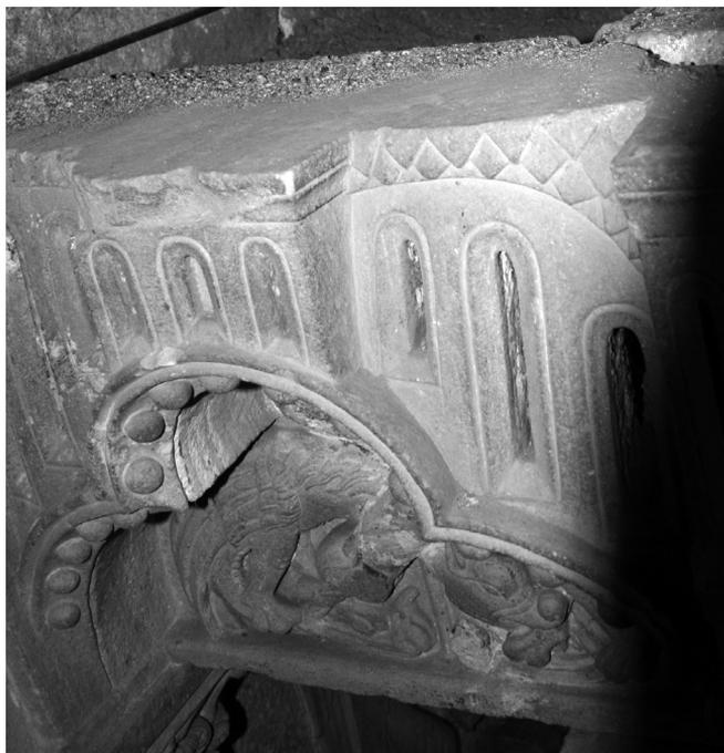
*Fig 3a. Remate del sepulcro de la Magdalena de Zamora. Orificio en la esquina para hincar un vástago y asentar un bloque superior con posible coronamiento cupulado.*
