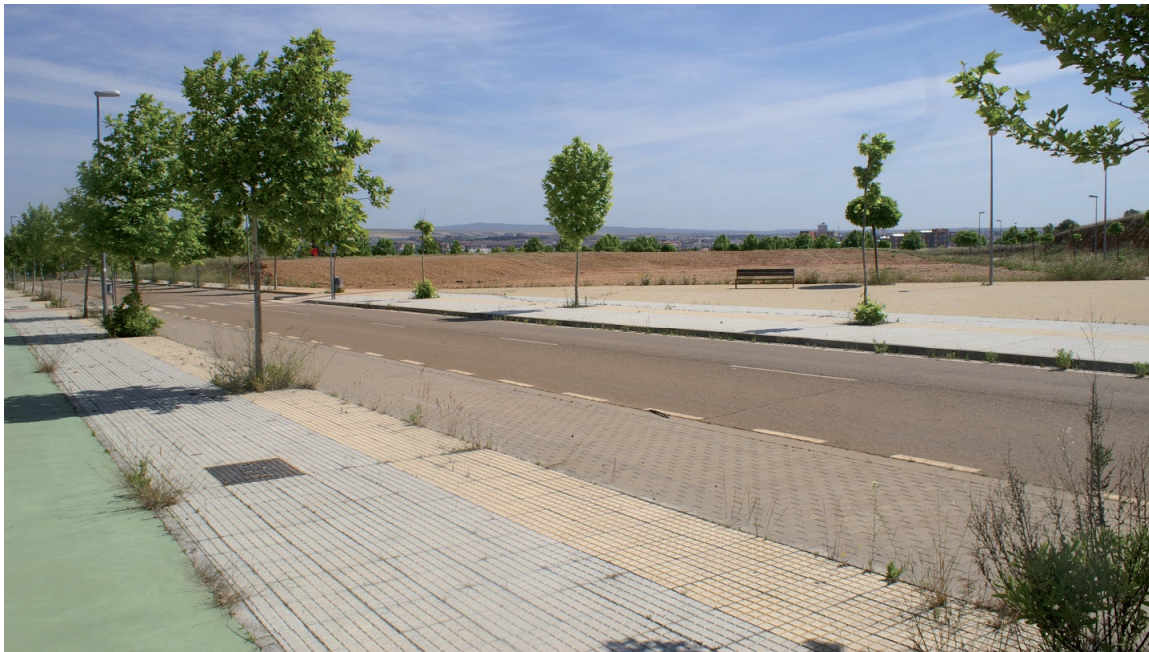
Figura 3. Vista de una de las calles de los nuevos ensanches urbanos en la ciudad de Mérida (España)
