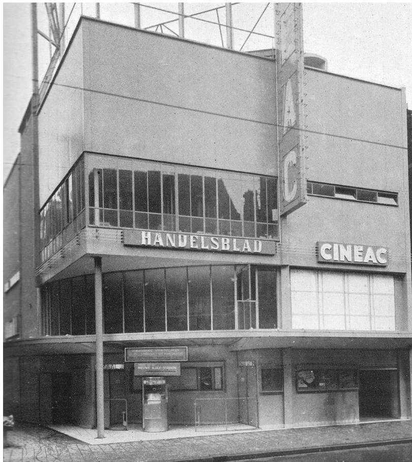
▲ Figura 10. Vista diurna, fachada principal del Cinéac Handelsblad (Amsterdam)
