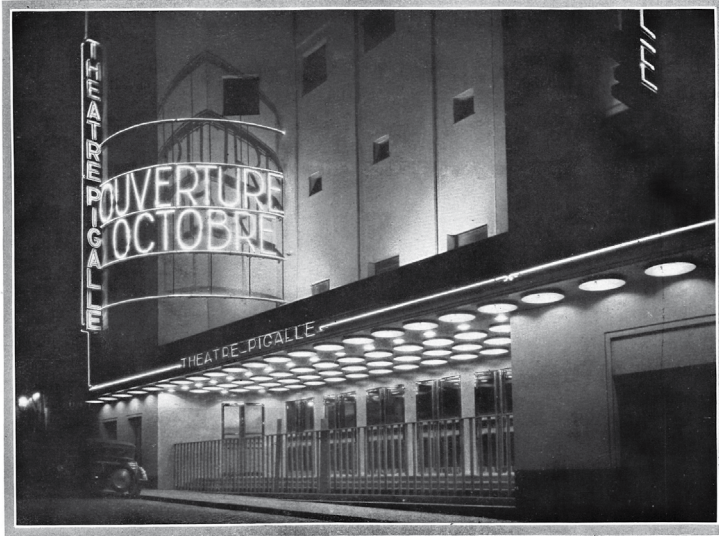
Fig. 1. — Façade du théâtre Pigalle.
