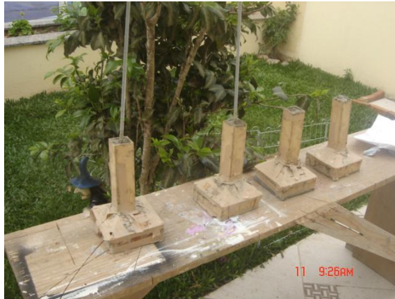
Figura 9: Construção das sapatatas.
