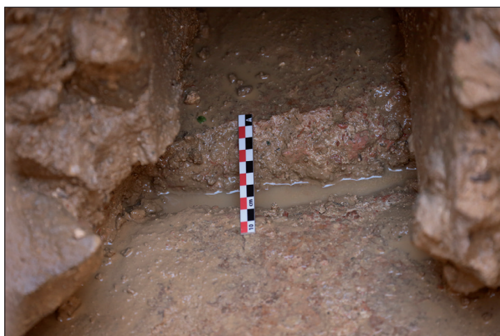
Figura 10. Hendidura en el suelo de hormigón.
