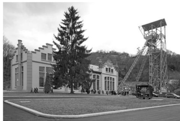
Figura 7. Casa de máquinas y castillete del pozo San Luis. (Fuente: Ayuntamiento de Langreo).
