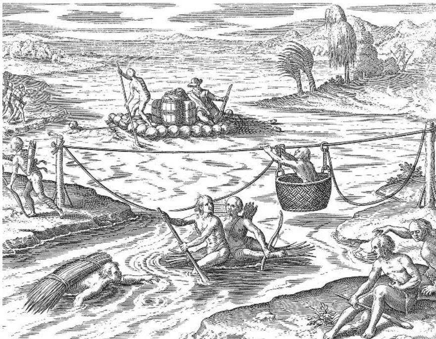
Figura 12. En primer término, una balsa de enea. Se aprecian también una balsa de calabazos arrastrada a nado por el balseiro y un ayudante con pértiga, y una oroya. Comienzos del siglo XVI.
