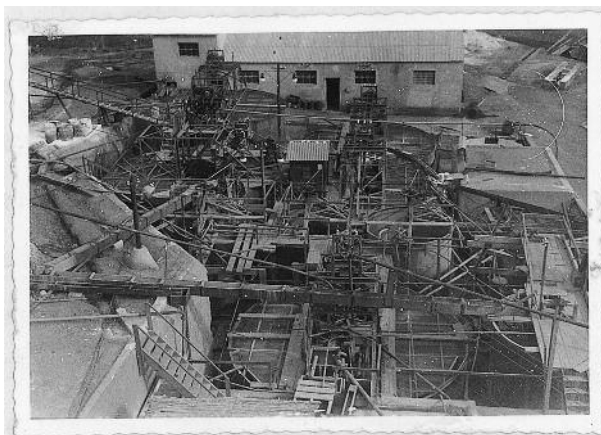
Figura 12. Instalación metalúrgica de cianuración de la compañía Minas de Rodalquilar S.A. , localizada en Rodalquilar. Inició su actividad en 1931 bajo el impulso de la citada compañía (Biblioteca de la Escuela de Minas de Madrid).
