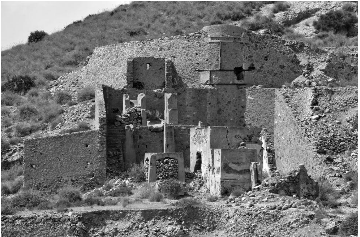
Figura 10. Instalación metalúrgica de amalgamación localizada en la mina "María Josefa". Inició su actividad en 1925 bajo el impulso de Juan López Soler.
