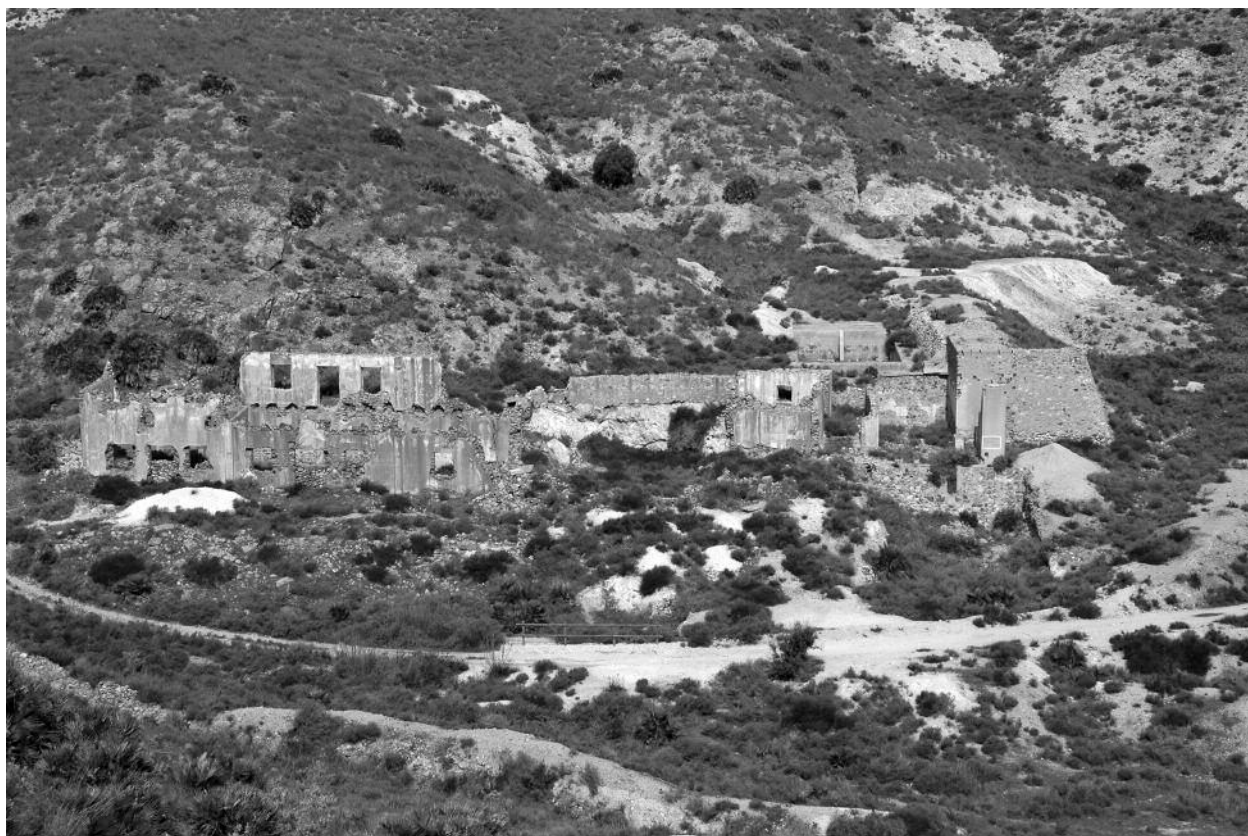
Figura 11. Instalación metalúrgica de amalgamación de la compañía EMARSA, localizada en Rodalquilar. Inició su actividad en 1929 bajo el impulso de Antonio Abellán.
