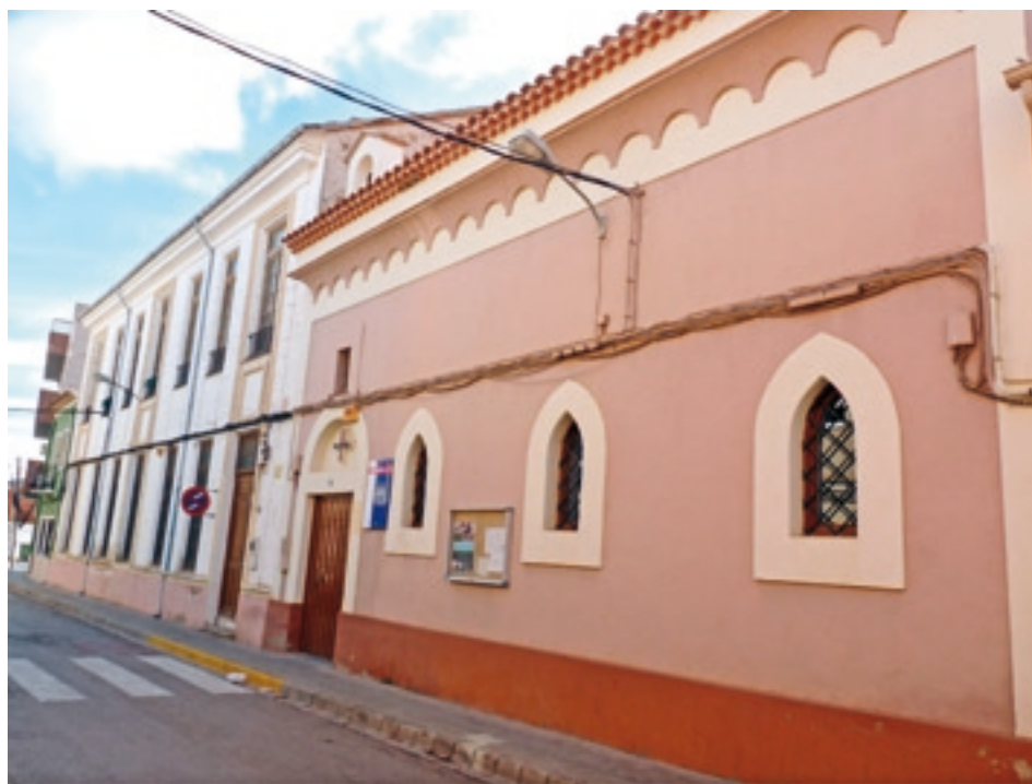
Foto 1. Fachada del colegio de las monjas en la actualidad (cedida por José Arsenio Valero Cano).
