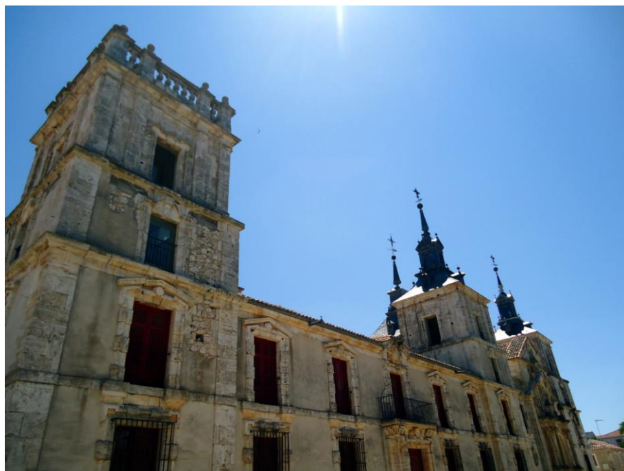
Fig. 3. Fachada del palacio de Nuevo Baztán.
