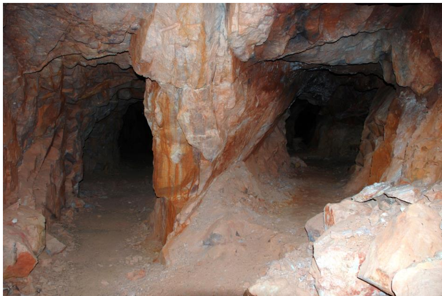
Fig. 5. Bifurcación de la galería principal del socavón Dos de Mayo (Autores).
