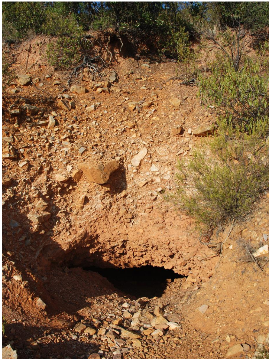
Fig. 2. Estado actual de la entrada al socavón Dos de Mayo (Antores).
