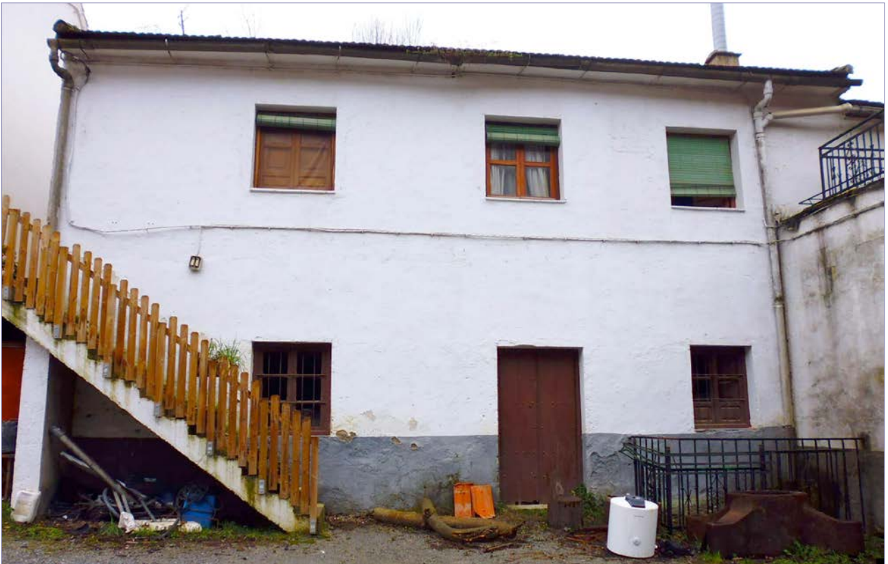
Fig. 5. Fachada principal del molino de Muñoz. (Fotografía de la autora).
