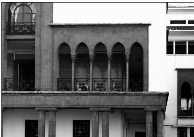
Fig. 9. Hotel de ville, detalle de fachada.
