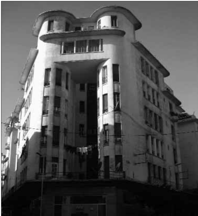
Fig. 24. Edificio Levy Bendayan.
