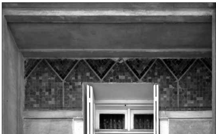
Fig. 19. Detalle del edificio Ugazio.
