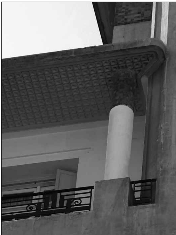
Fig. 18. Detalle del edificio Ugazio.
