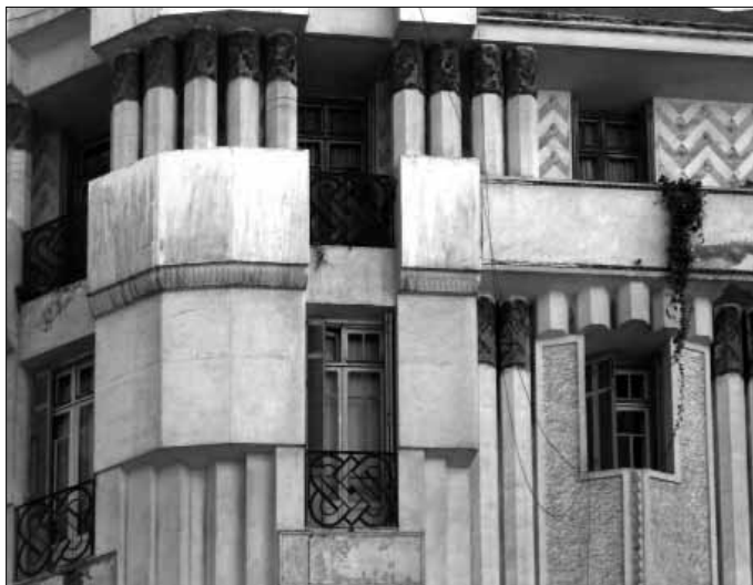
Fig. 15. Detalle del edificio Benaroch.
