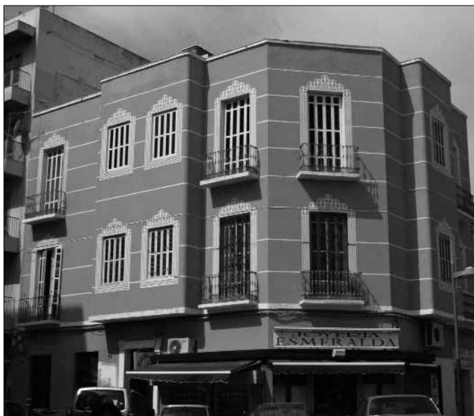
Fig. 26. Edificio en la calle Sidi Abdelkader, 9. Arquitecto Enrique Nieto Nieto, primera mitad años cuarenta.
