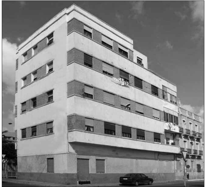
Fig. 12. Edificio en la calle General Astilleros, 25. Arquitecto Francisco Hernanz Martínez, 1933.
