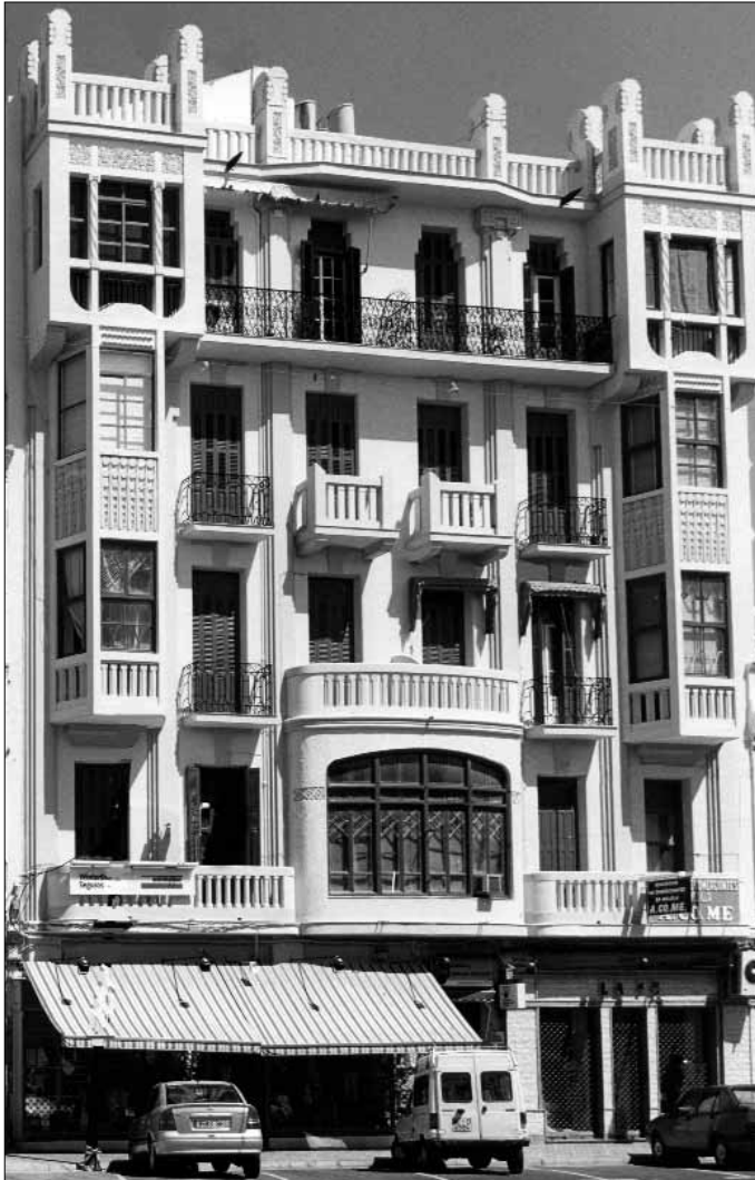
Fig 8. Edificio en la calle General Chacel, 8. Arquitecto Enrique Nieto Nieto, 1936.
