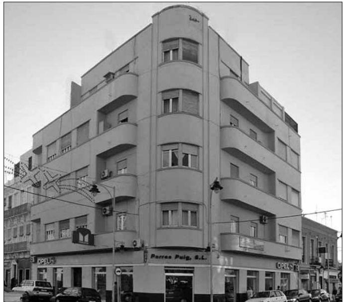
Fig. 16. Edificio en la calle General O'Donnell, 41. Arquitecto Francisco Hernanz Martínez, 1933-1936.
