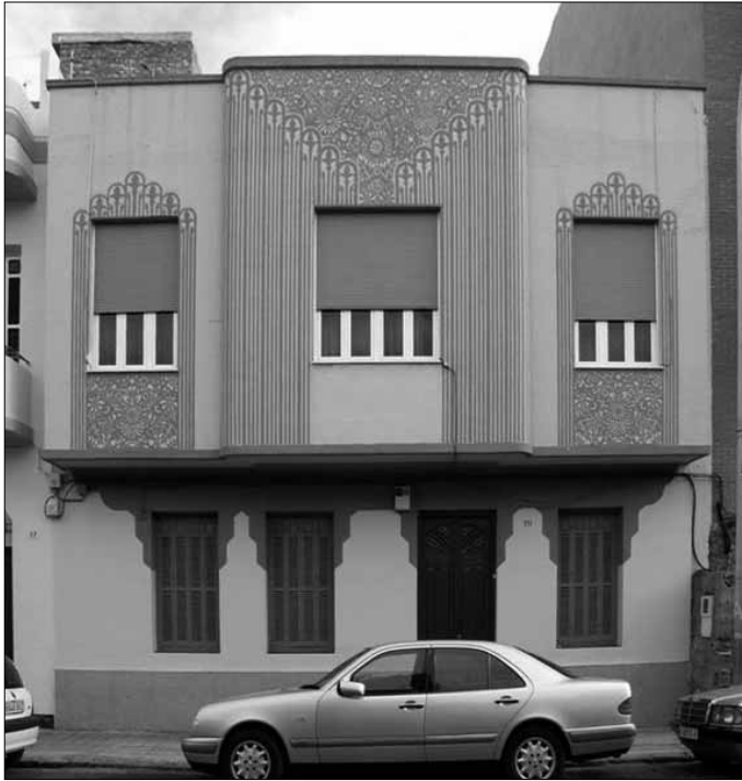
Fig 24. Edificio en la calle Aragón, 21. Arquitecto Enrique Nieto Nieto, primera mitad años cuarenta.
