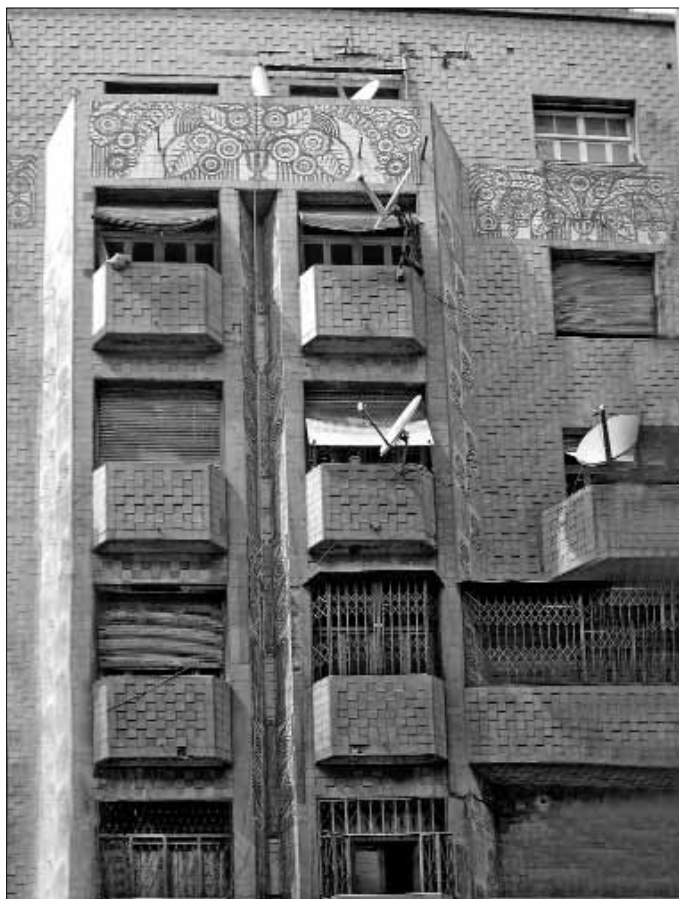
Fig 6. Immeuble rue docteur Saadane (architecte Xavier Salvador).
