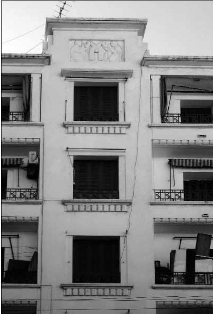
Fig 17. Immeuble rue Hassiba Ben Bouali (architecte Marcel Lathuillière).
