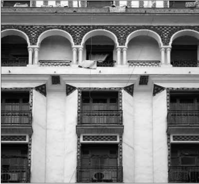
Fig 4. Immeuble, rue Abane Ramdane, (architecte Paul Guion).
