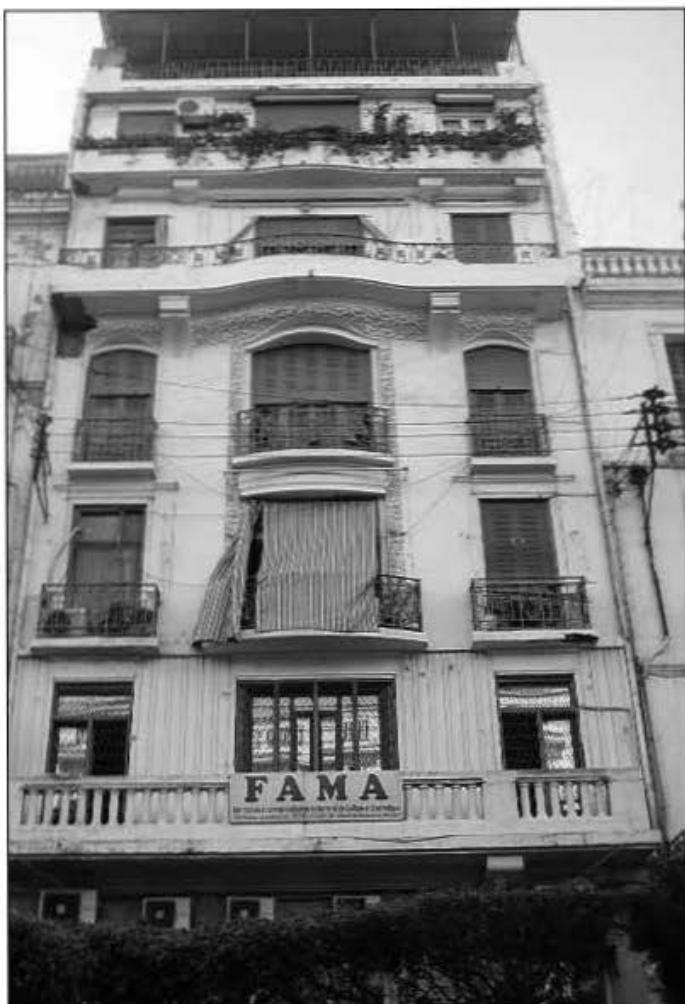
Fig. 18. Immeuble, rue Didouche Mourad.
