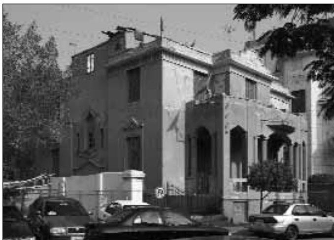
Fig. 17. Propriété Anette Chalaby, Villa à appartements, Fahim Riad, arch., 1931 (Le Caire, Heliopolis Housing and development company).
