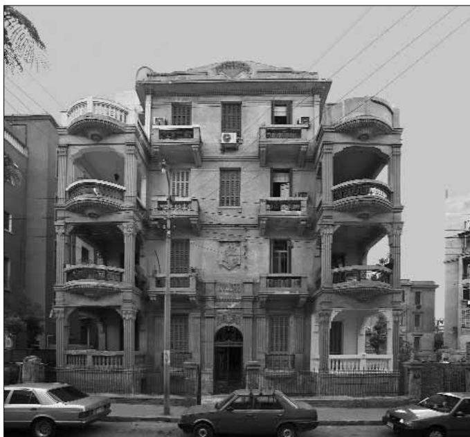
Fig 13. Immeuble Sami Habib Chalaby, Edouard Cherini, arch., 1931 (Cliché Mercedes Volait).
