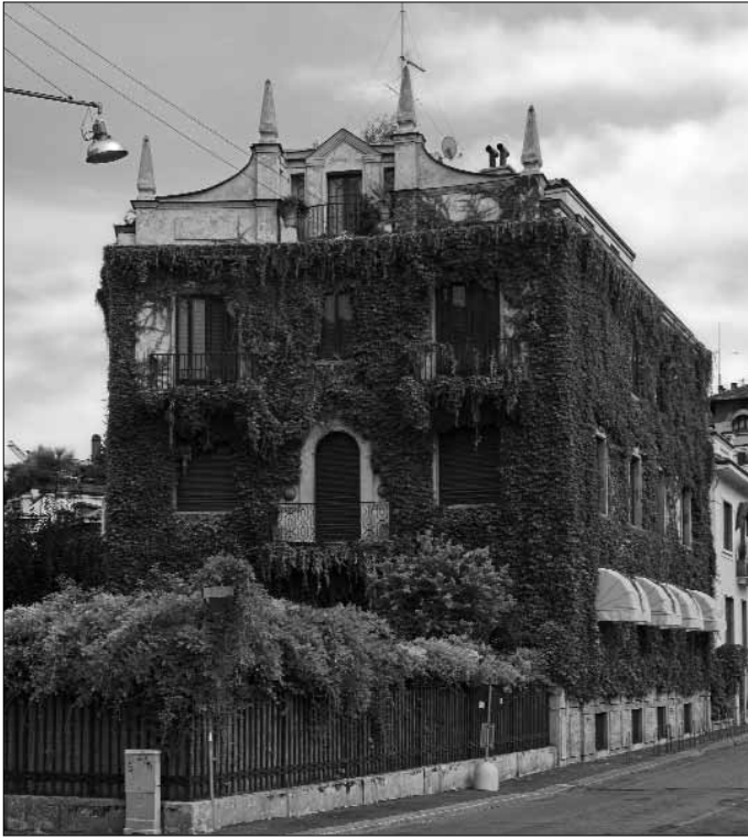
Fig 14. Immeuble rue Randaccio 9, Giò Ponti 1924-1926.
