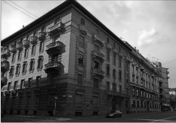
FIG. 4. Immeuble en rue Carducci 16, arch. C. Ravina 1925-1927.
