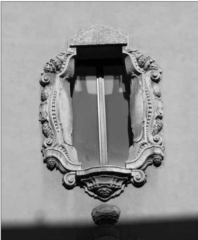
Fig. 5. Immeuble en rue Carducci 16, arch. C. Ravina 1925-1927.
