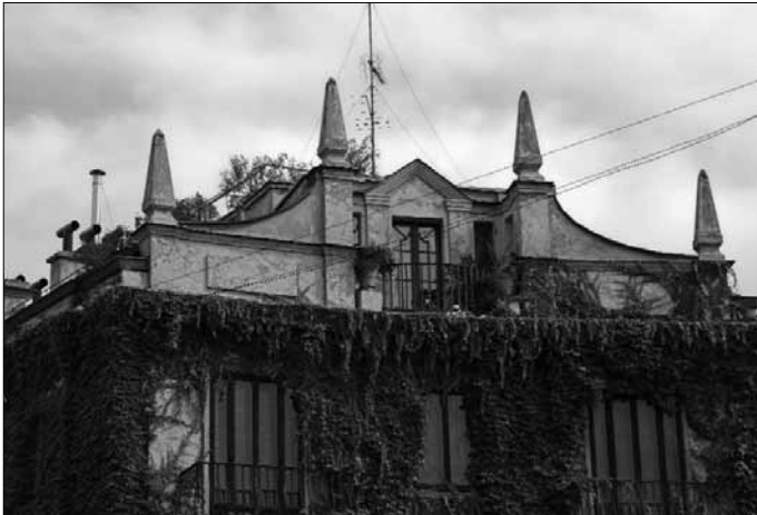
Fig 2. Immeuble rue Randaccio 9, Giò Ponti 1924-1926.
