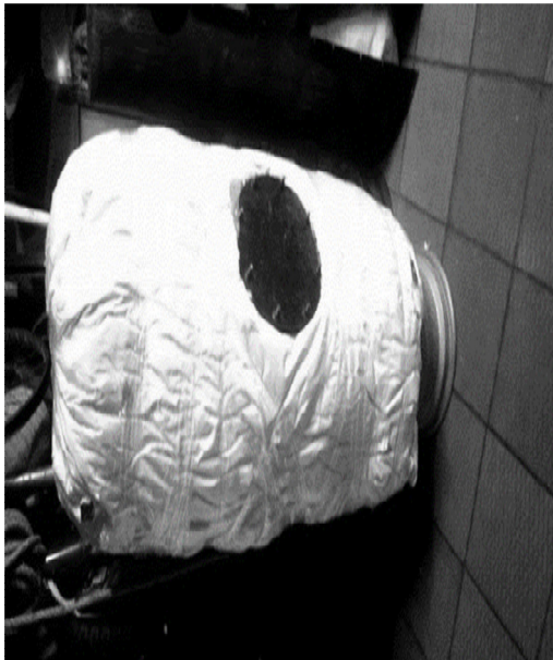
Figura 8. Montaje aislante (lana de vidrio)
