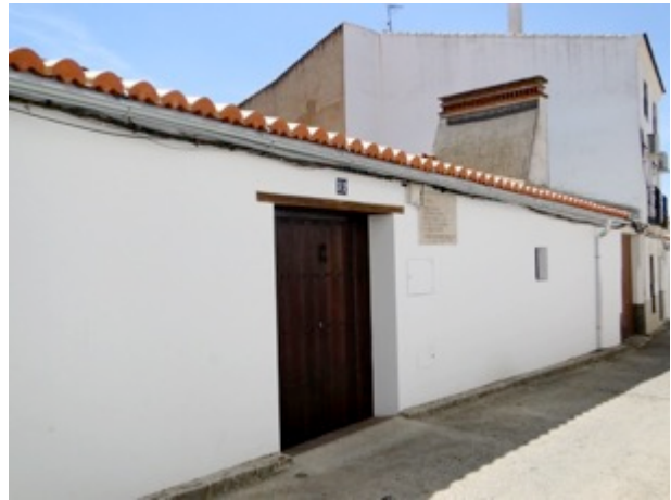
Fig. 12. Casa museo de Zurbarán en la calle Águilas, antes Caño de las Barrigas.
