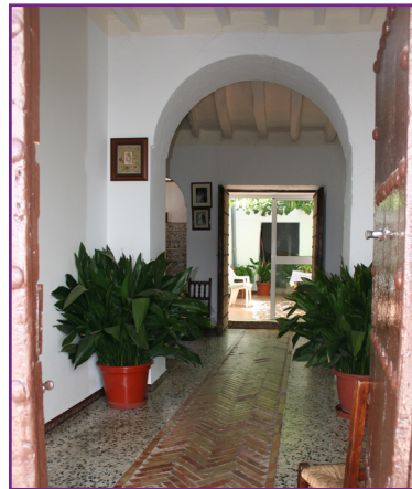
1. Paso de caballerizas de una vivienda propia de una localidad basada su economía en las actividades agropecuarias realizado con morteretes dispuestos en “espina de pez”
