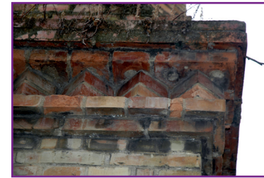
Figura 10: Doble hilada a serreta por tabla en columnilla. Cornisa de Aceites Miranda, Andújar (Jaén)
