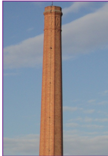
Figura 16: Corona y fuste de bodega en Huércal de Almería (Almería)
