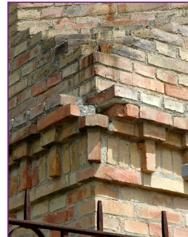
Figura 11: Pieza especial sobre T en esquina. Fábrica de cartones Muro de Alcoy (Alicante)
