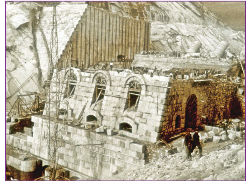
Fig. 3. Aspectos de la construcción
