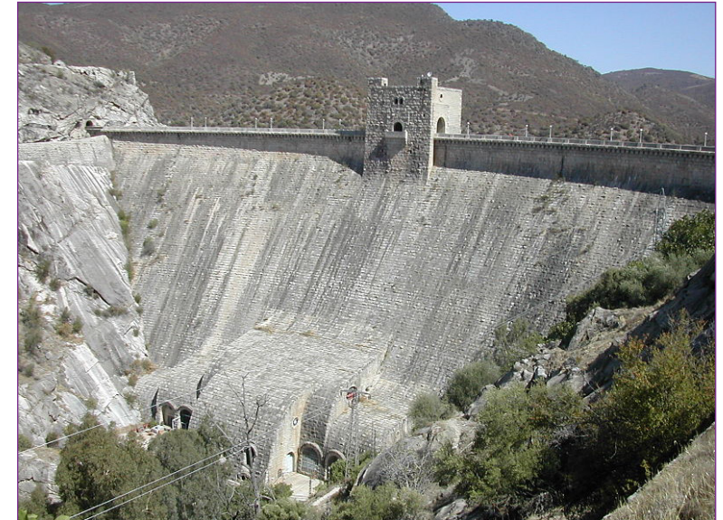
Fig. 1. Presa del Jándula. Estado actual
