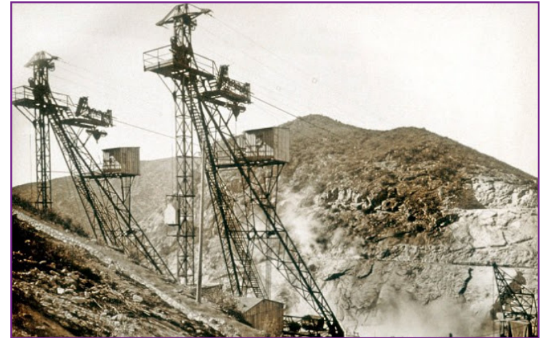
Fig. 5. Aspectos de la construcción
