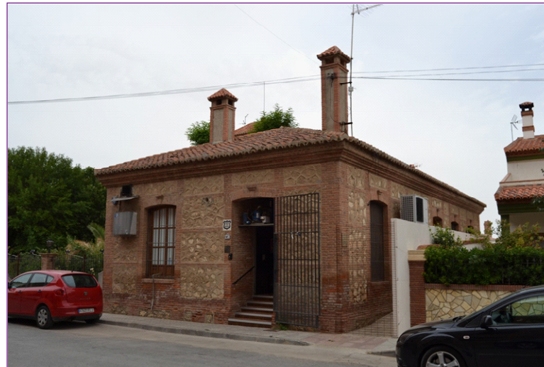
02. Oficina de cultivos/Laboratorio rehabilitado. A.M. Díaz Muñoz (2013)
