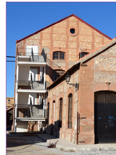
04. Cuerpo de fábrica y Almacén de útiles rehabilitados. A.M. Díaz Muñoz (2013)
