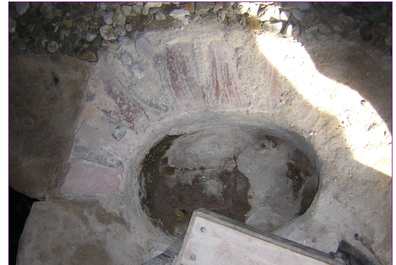
Foto 3. Detalle de boca de vertido del agua junto al aljibe.
