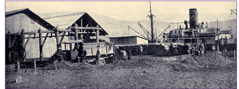
Fig. 2. Labores de carga y descarga en el Puerto de Motril. Fuente: Actas TEGSA 1929.
