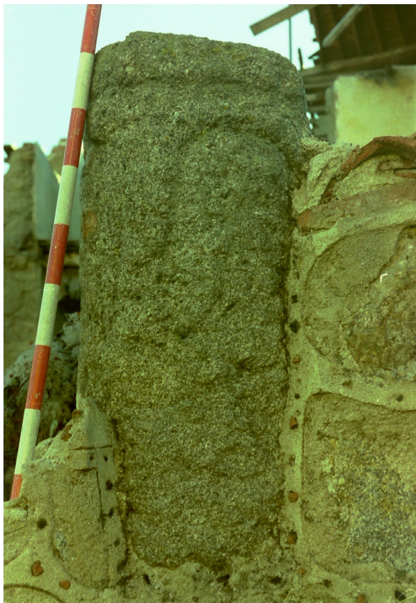
Cipo de granito reutilizado en el aparejo del cierre occidental del inmueble.
