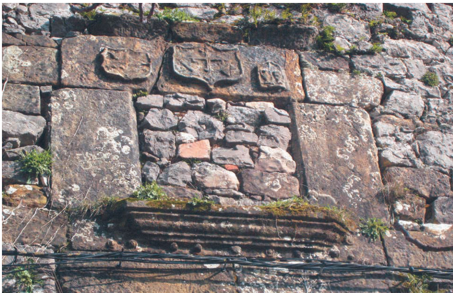
Fig. 4. Armerías de Mier en la casa denominada «el Palacio» (Rozagás, Peñamellera Alta)
