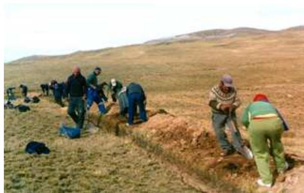
**Fotografía N° 3: levantamiento y tarrajeo de la caja del desarenador.**
