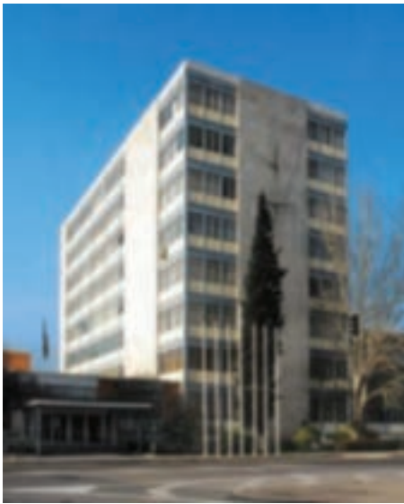
2. Edificio social del INEF de Madrid
