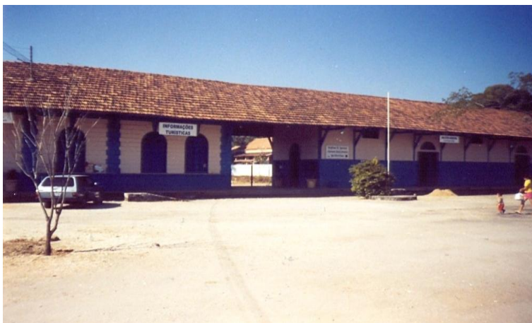
Figura 3. Estação Ferroviária de Pirapora/MG
