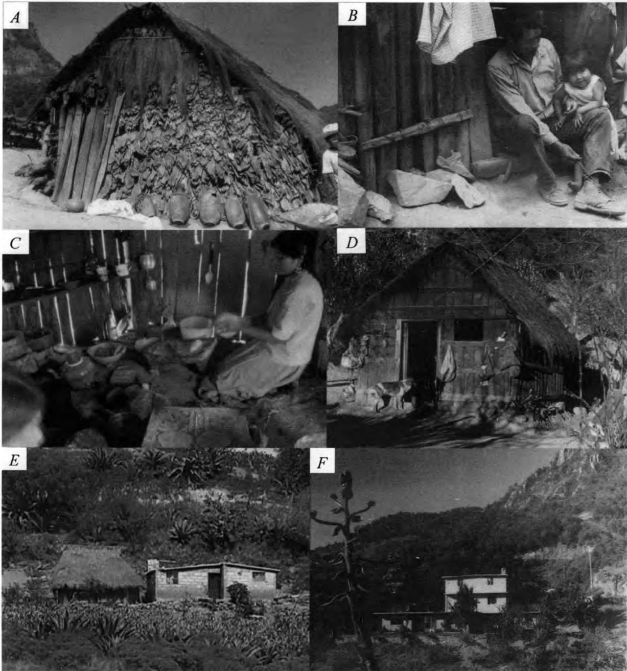
**Figura 8.** Evolución de las casas en Gundhó. *A.* Pared de penca de maguey y puerta de postes (1972), *B.* Detalle de casa con palos atados con *xixi* (1970), *C.* Interior de una casa construida con palos y tablas (1973), *D.* Tablas clavadas a barras horizontales (1975), *E.* Casa vieja de palos y techo de pasto adyacente a otra construida de tabicón, *F.* Casa de tabicón de tres niveles, donde se observa un quiote a la izquierda, lo cual significa que no están raspando el maguey (1999).
