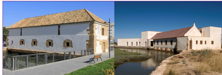
Ilustración 2. Molinos de mareas El Pintado (dcha.) y Zaporito (izq. J. F. Luque Delgado), ya rehabilitados
