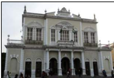
Figura 1: Vista externa del TJA
