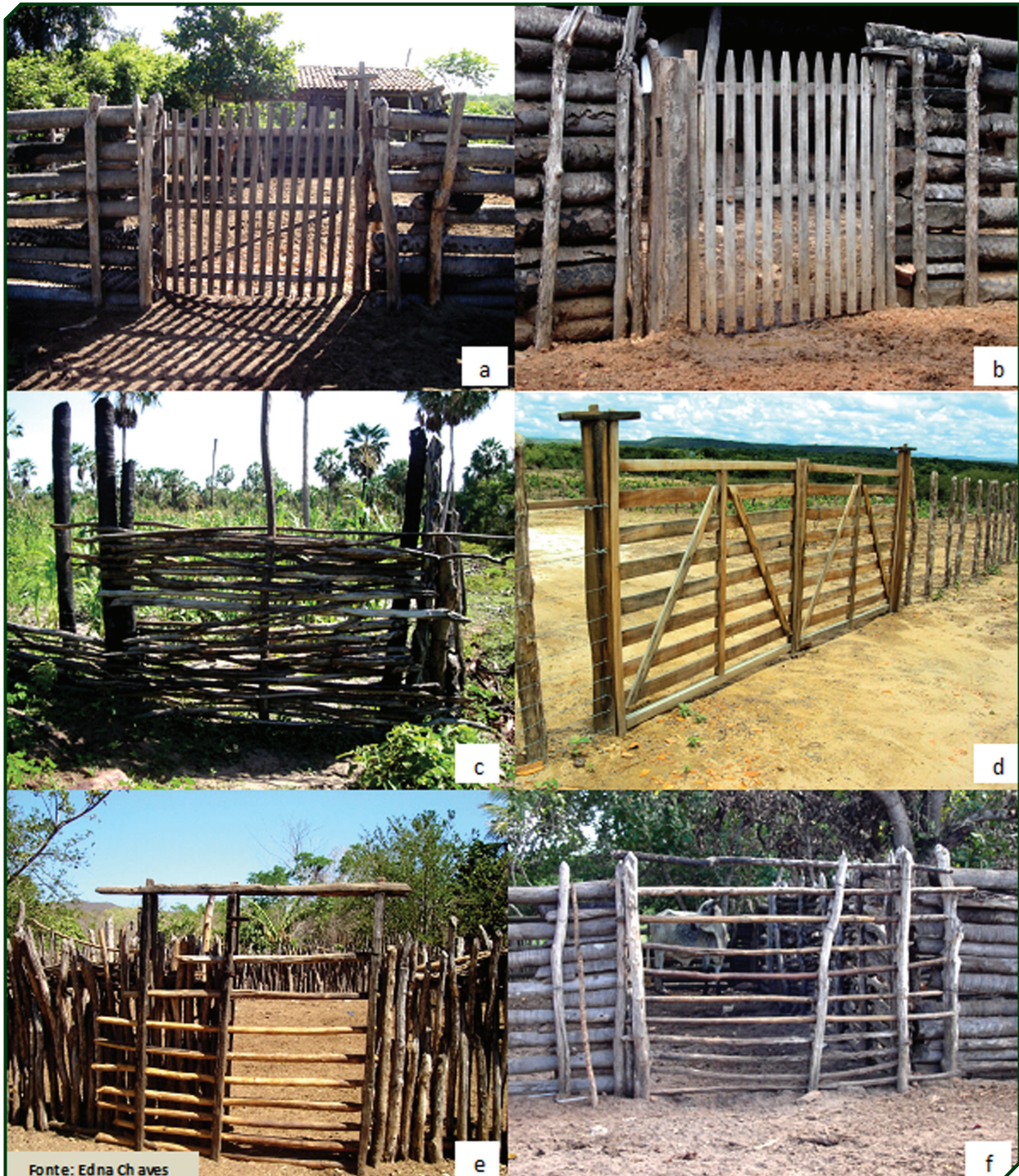
Figura 4. Passagens de cercas de madeira utilizadas no município de Cocal, Piauí: a, b - Cancelas; c - Passador; d - Portão; e, f - Porteiras. Fonte: Edna Chaves
