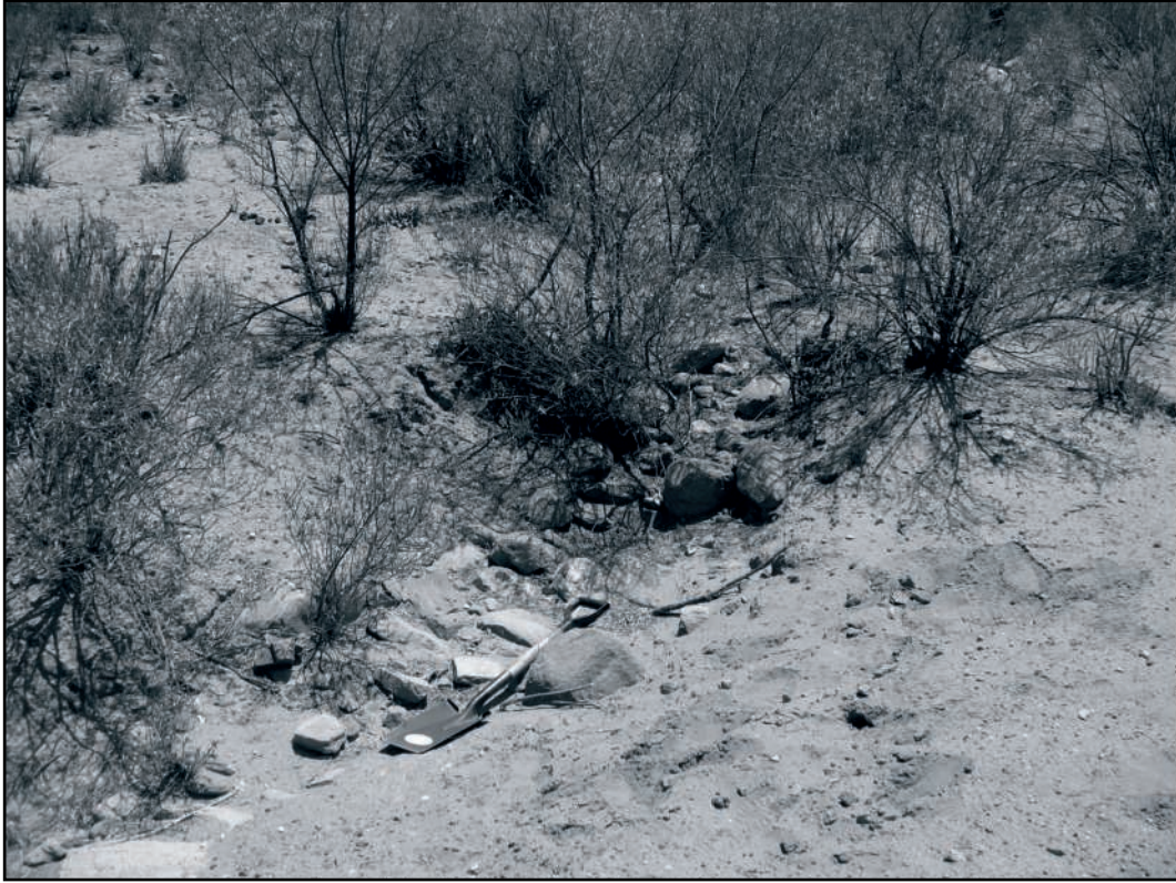
Figura 4. Vista de un sector del canal.
