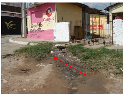
Foto1: Desagüe a cielo abierto en Jacumã
