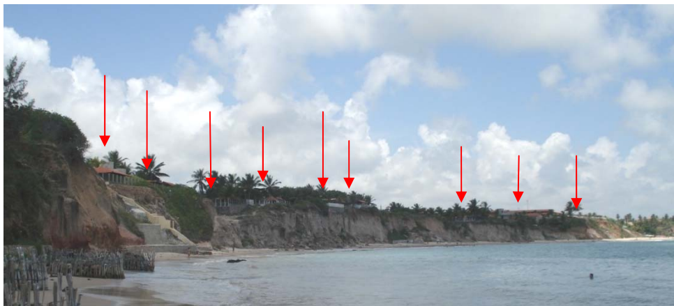
Foto 3: Construcciones irregulares – borda de falésia, Carapibus
