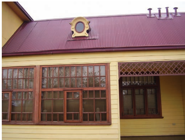
Figura N.6 Vivienda pre intervención. Foto: Tirza Barría.
