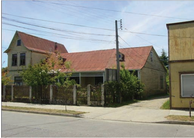
Figura N.4 Vivienda pre intervención. Foto: Tirza Barría
