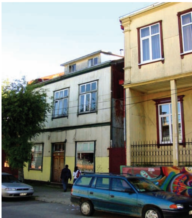
Figura N.8 Vivienda pre intervención. Foto: Marta Scheu
