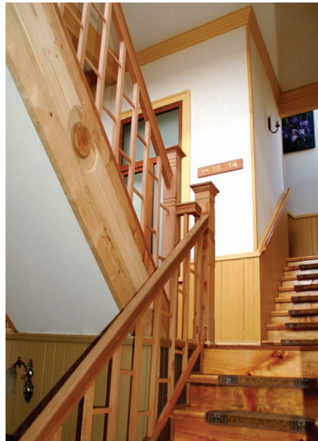
Figura N.9 Detalles interiores. Foto: Marta Scheu
