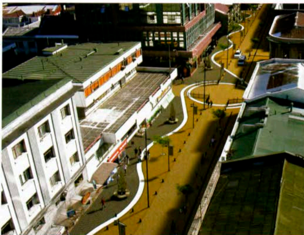
Renovación urbana en área central de Concepción.
