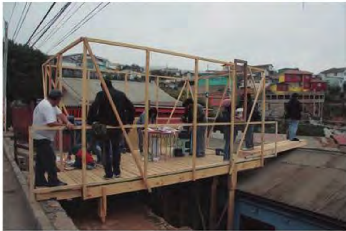
Figura 4,5,6 y 7 Proceso constructivo de instalación "La Casa inacabada" - Con Caupolicán Acevedo, Héctor Silva, Emanuela di Felice, Pau Faus y Claudio Astudillo. Fotografía de Pau Faus.
