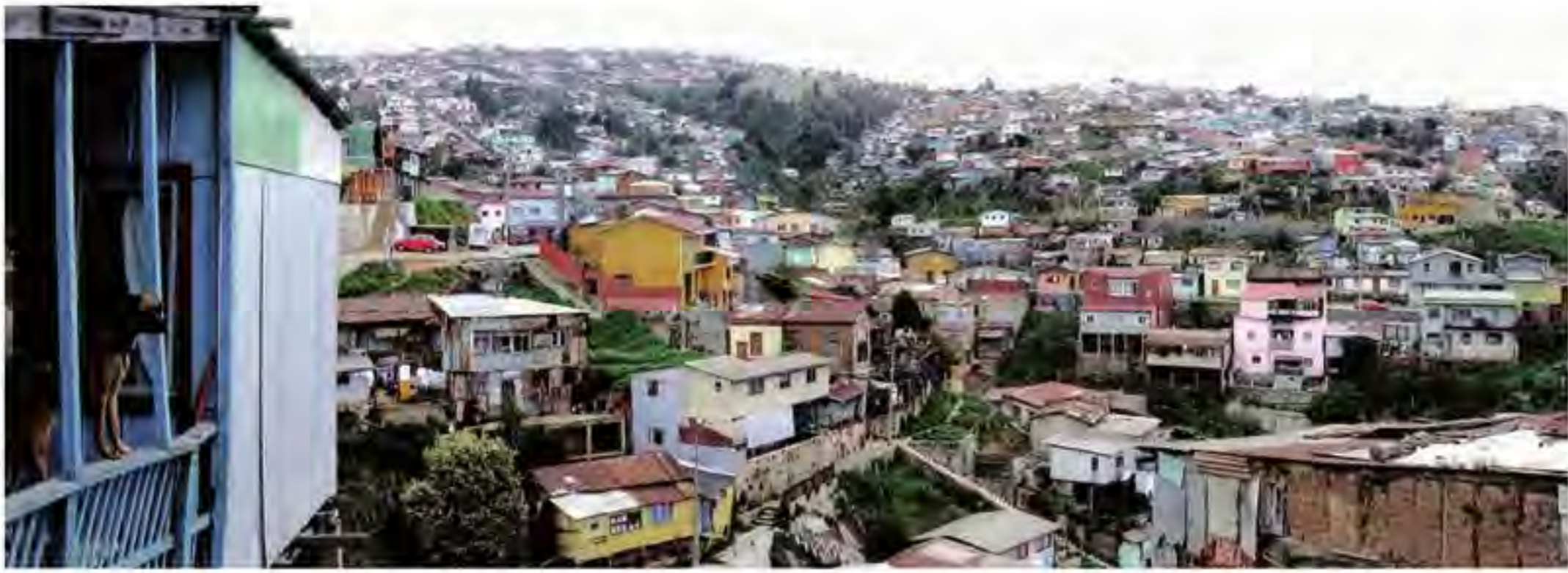
Figura 1 Paisaje del Cerro Cordillera, donde existe una enorme cantidad de viviendas autoconstruidas. Fotografía por Pau Faus
