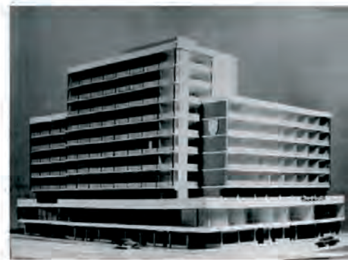
8 Maqueta de la época Edificio Fiuc
