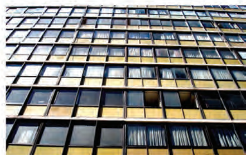
2 Fachada Caupolicán Edificio FIUC
