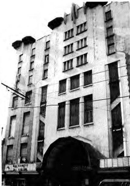
Edificio Ermita. Arq. Juan Segura, 1930-36. Edificio polifuncional Art Decó con departamentos, oficinas, comercio y cine.
