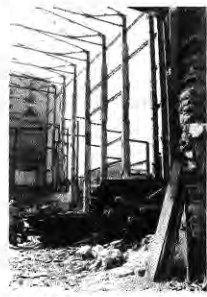
Demolición del edificio y cine Roble, en el Paseo de la Reforma, uno de los de mayor tradición en la ciudad
