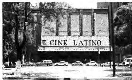
Aspecto actual del cine Latino, también en Reforma, hoy en obras de remodelación, convertido de una en tres salas de exhibición.
