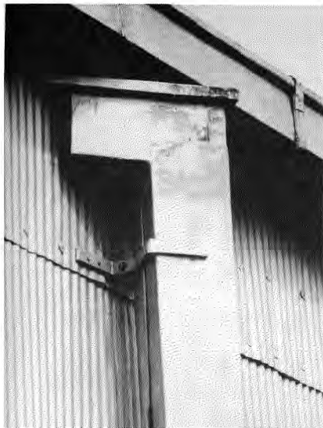
Corral: Detalle bajada aguas lluvias.
