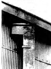
Corral: Detalle bajada de agua.
